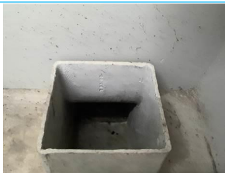
Matériaux : ZPSO-001 Prélèvement : Description : Conduit en fibres-ciment de ventilation Localisation : Sous-Sol - Local technique Ascenseur IA S04 Résultat : Présence d'amiante
